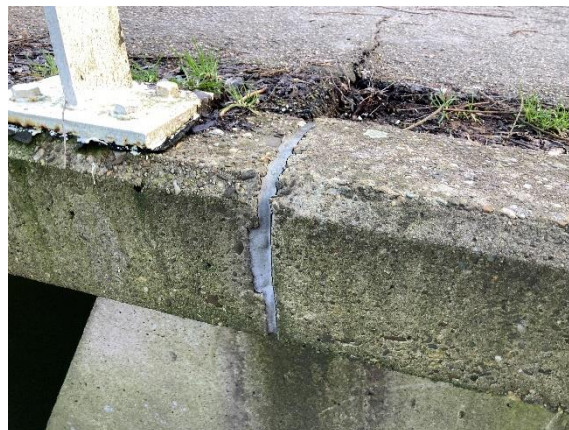
Schade: Functie afwezig voegafdichtingen Oorzaak: Eindelevensduur Risico: Aantasting onderliggende betonnen constructie door vochtintreding met als gevolg afname draagkracht en verminderde restlevensduur beton Maatregel: Kitvoegen vervangen
