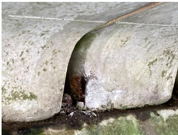
Schade: Loskomend reparatie mortel en holklinkende plekken waar reparaties zijn uitgevoerd Oorzaak: Reparatiewerkzaamheden niet juist uitgevoerd Risico: Verdere aantasting wapeningsstaal met als gevolg afname draagkracht en verminderde restlevensduur beton Maatregel: Betonreparatie conform CUR-Aanbeveling 118
