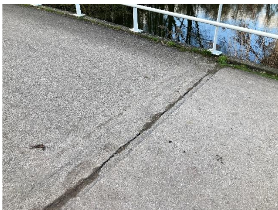
Schade: Ernstige lekkage voegovergangen Oorzaak: Ontbreken van een deugdelijke voegconstructie Risico: Aantasting onderliggende betonnen constructie door vochtintreding met als gevolg afname draagkracht en verminderde restlevensduur beton Maatregel: Aanbrengen/vervangen voegovergangen
